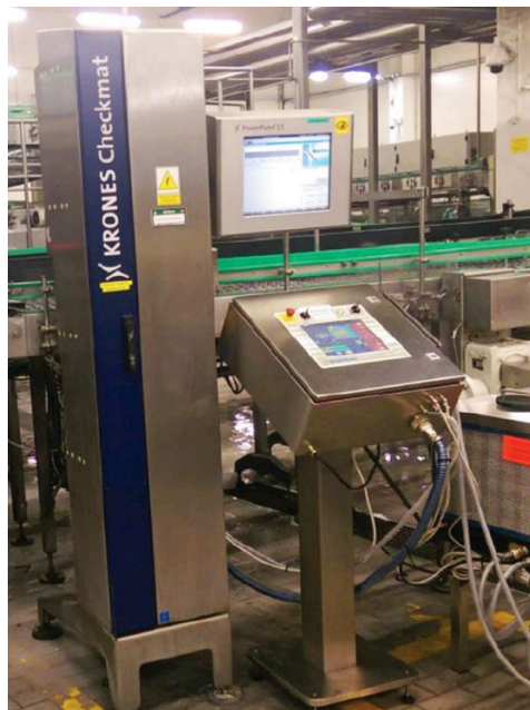
Instalovaný CO 2 Laser Solaris ve stáček lince Krones před výstupní kontrolou
